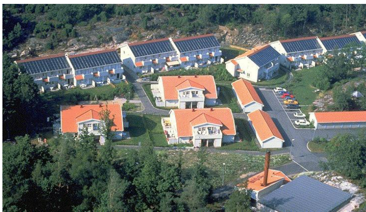
Ηλιοθερμικά συστήματα για θέρμανση χώρων στη Σουηδία
