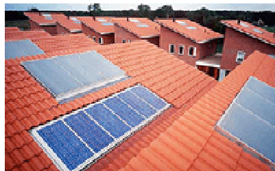
Ενσωμάτωση φωτοβολταϊκών σε στέγες κτιρίων
