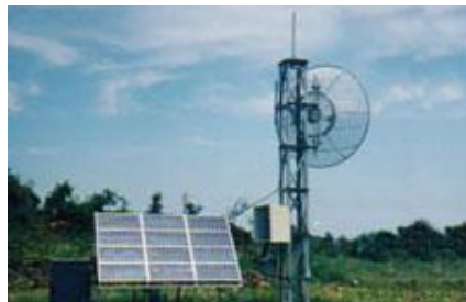
Εφαρμογή φωτοβολταϊκών στις τηλεπικοινωνίες
