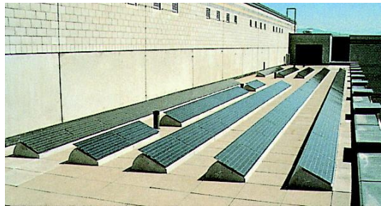
Εφαρμογή φωτοβολταϊκών σε ταράτσα κτιρίου
