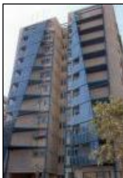
Ενσωμάτωση φωτοβολταϊκών σε πολυκατοικίες στον Ταύρο
