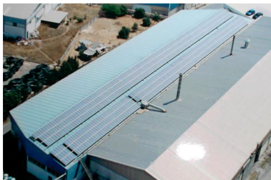
Εφαρμογή φωτοβολταϊκών σε στέγη εργοστασίου στην Κρήτη
