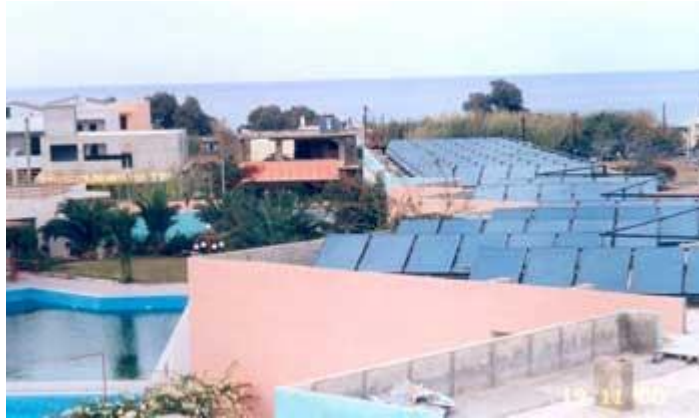
Εφαρμογή ηλιακού κλιματισμού σε ξενοδοχείο της Κρήτης
